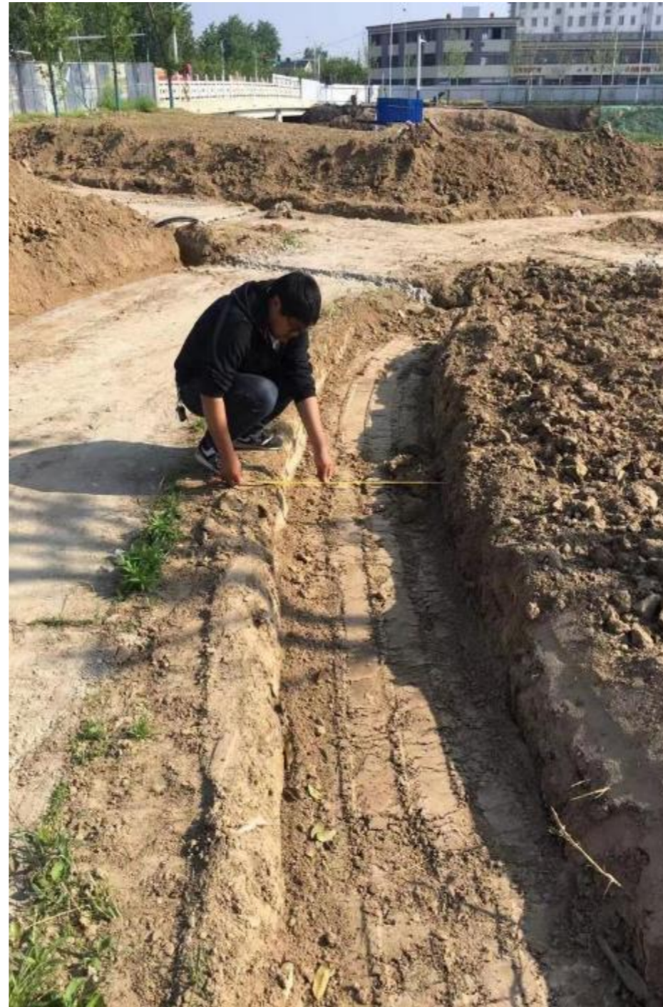
Bioswale construction
