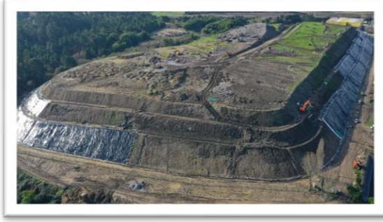
Landfill sealing [Valorminho & Resulima]
